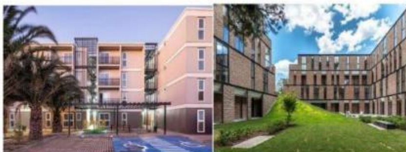
Imagen 17: Ejemplo de control visual y trabajo de fachadas en distintas alturas.
