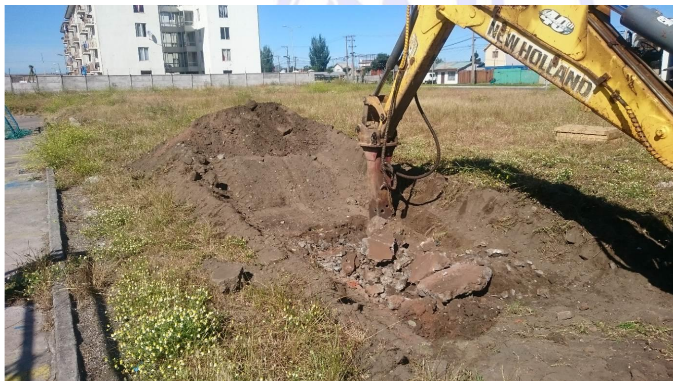
Figura 4.22: Ejecución de calicata C-1. Se observan radieres de hormigón de 12 cm de espesor
