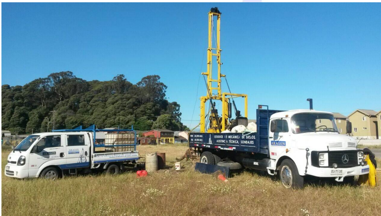
Figura 4.6: Emplazamiento y ejecución de sondaje SPT-2 de 5 m de profundidad
