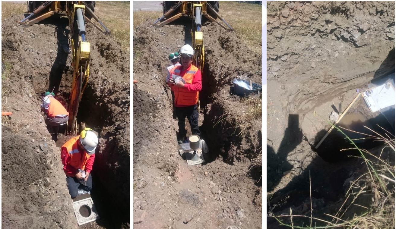
Figura 4.23: Densidad in situ y medición de infiltración en calicata C-1
