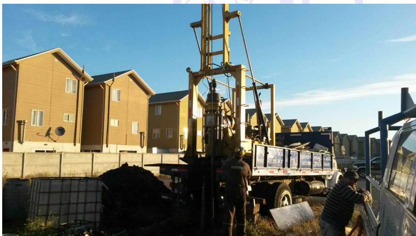
Figura 4.11: Ejecución de trabajos en sondaje SPT-4
