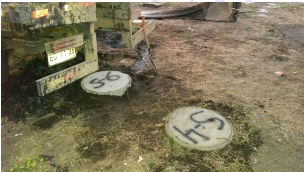
Figura 4.19: Cámaras de inspección para nivel freático en sondajes SPT-4 y SPT-6
