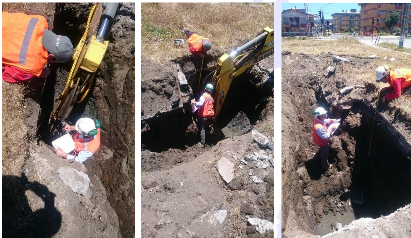
Figura 4.27: Inspección de calicata C-10. Se detectan rellenos artificiales hasta 0.96 m
