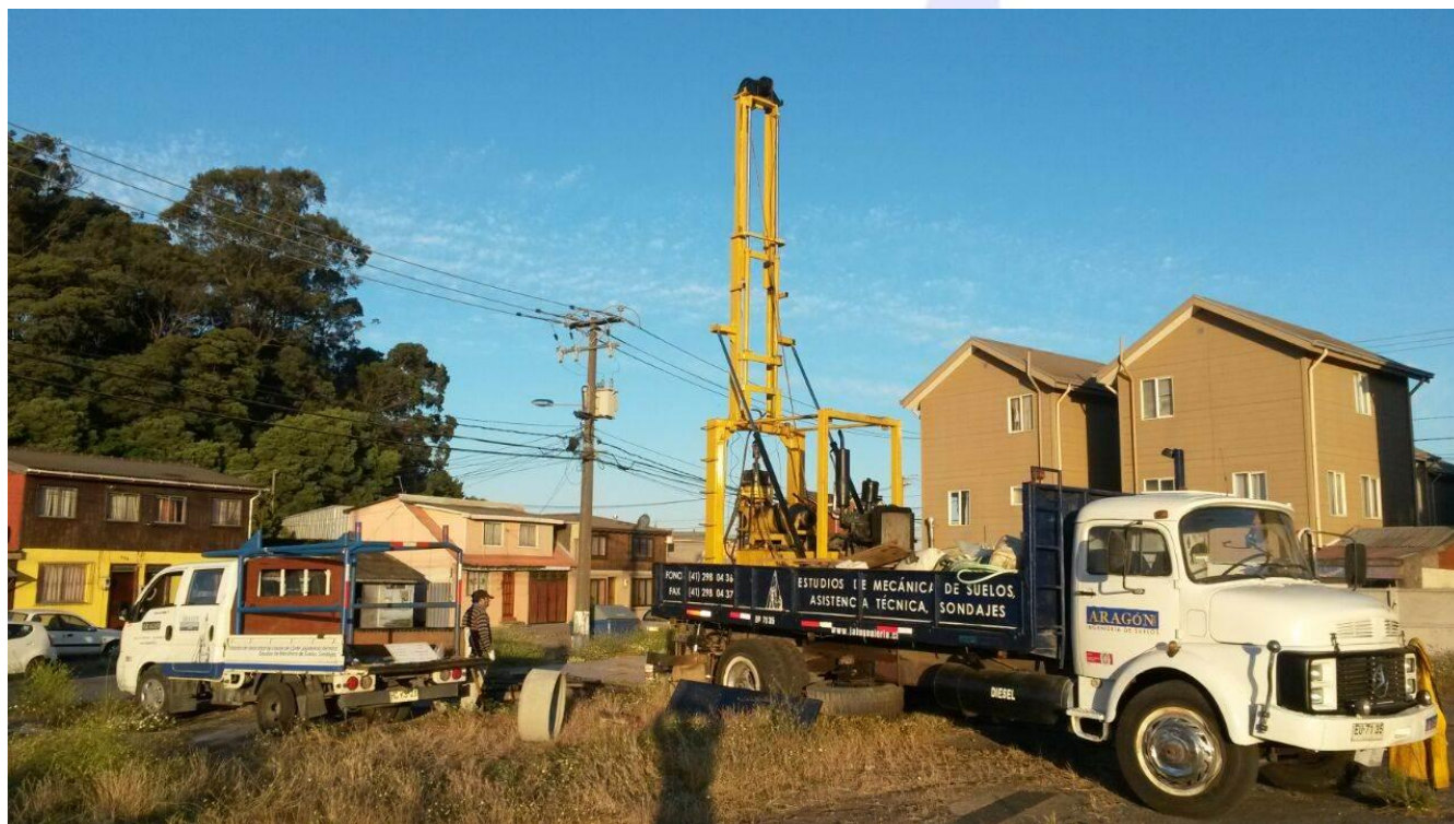
Figura 4.10: Emplazamiento de sondaje SPT-4 de 5 m de profundidad
