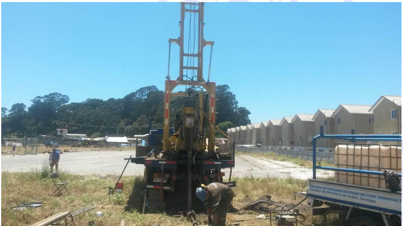
Figura 4.9: Ejecución de trabajos, vista hacia calle Manuel Rodríguez
