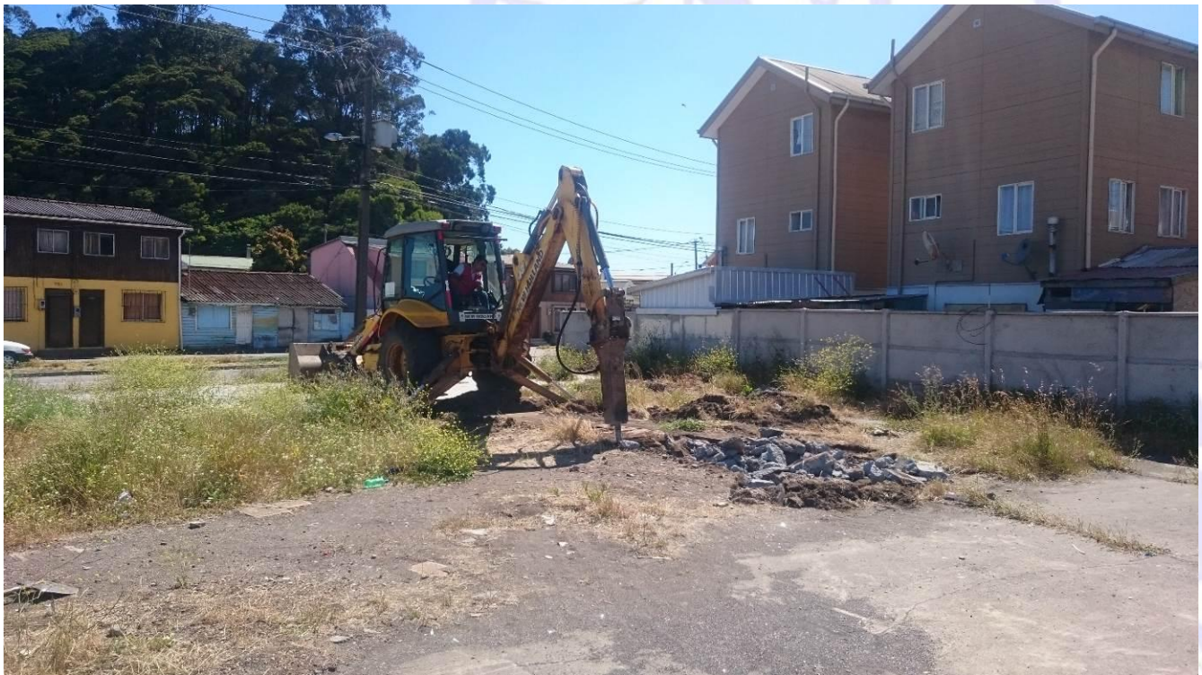
Figura 4.26: Ejecución de calicata C-7 y rotura de radier
