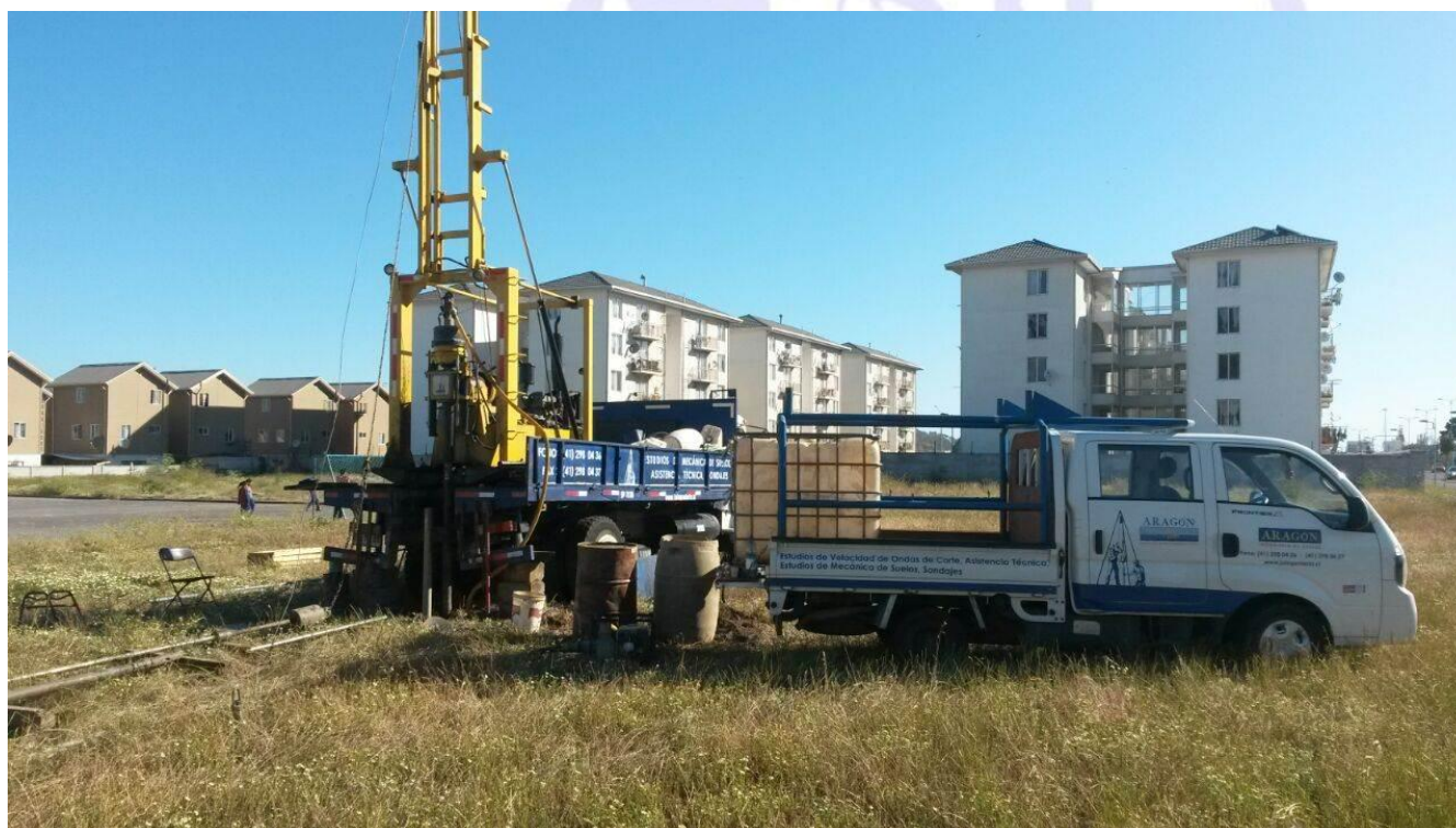
Figura 4.7: Ejecución de trabajos en sondaje SPT-2
