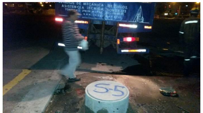
Figura 4.18: Cámaras de inspección para nivel freático en sondajes SPT-4 y SPT-5
