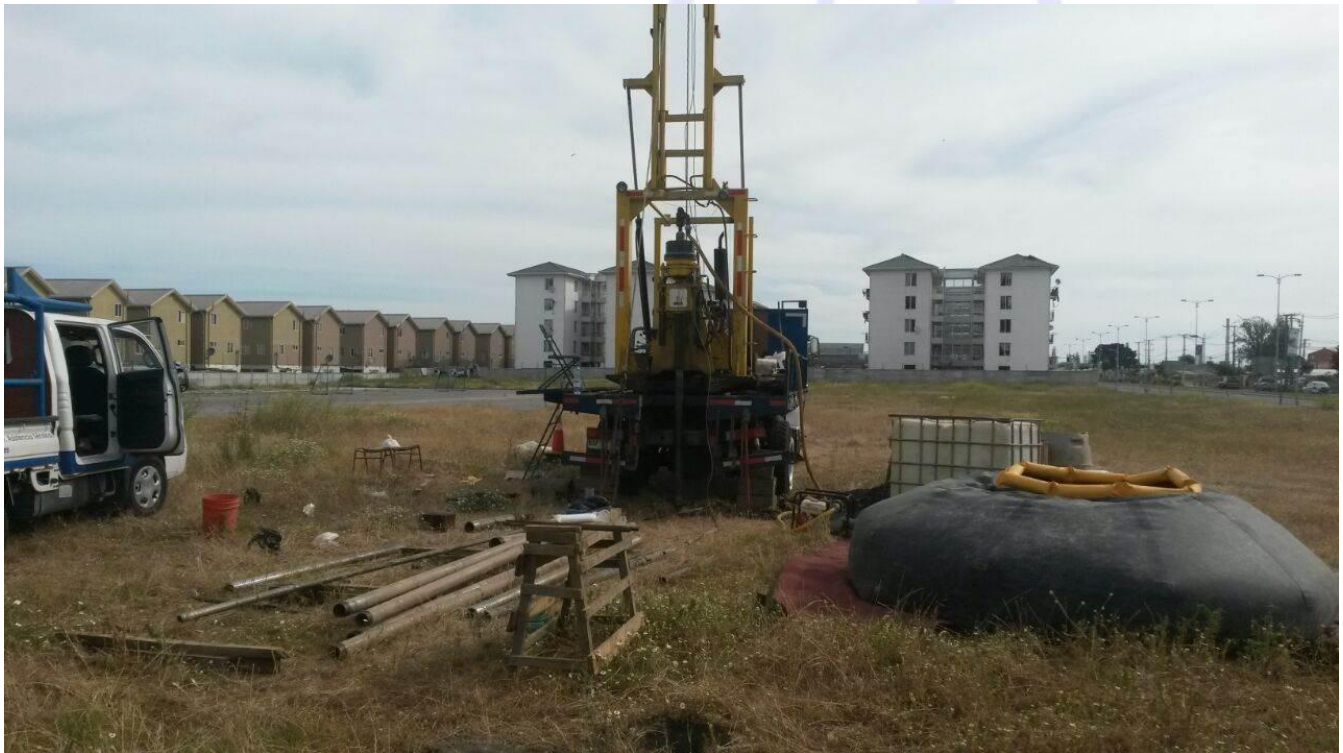
Figura 4.1: Emplazamiento y ejecución de sondaje SPT-1 de 30 m de profundidad
