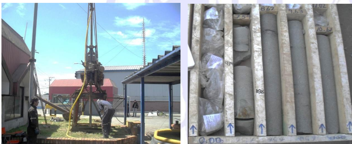
Figura 4.38: Ejecución de sondaje SPT-16 de 15 m de profundidad (2011)
