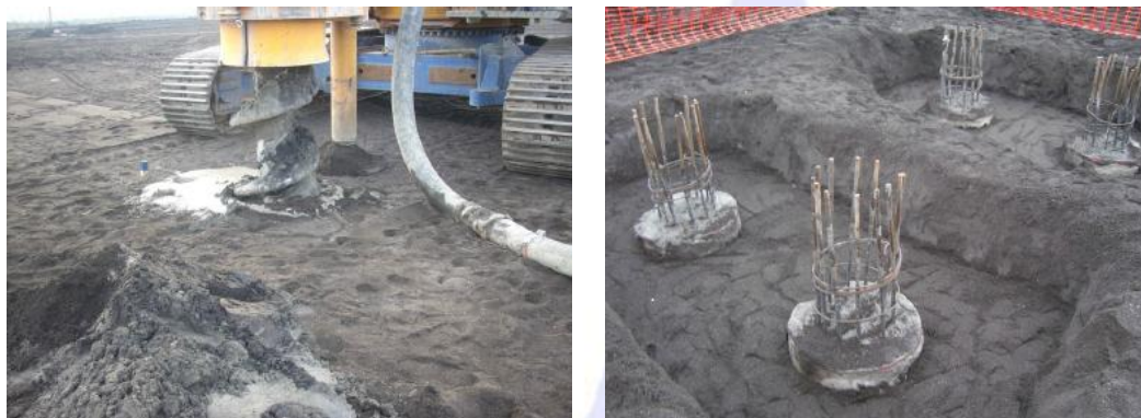
Figura 9.2: Ejecución en terreno de pilote CFA (tomado de Terratest)
