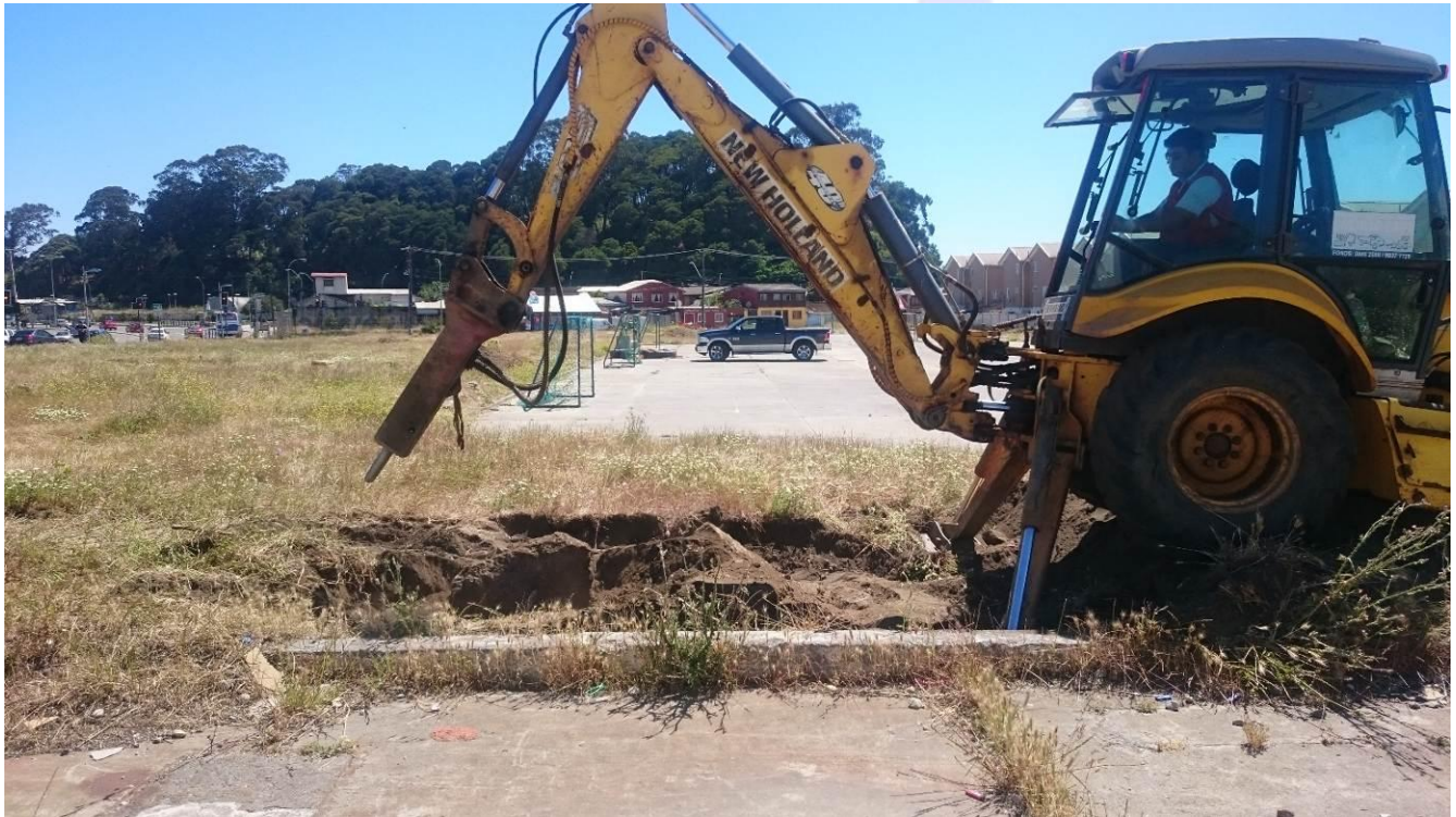
Figura 4.29: Ejecución de calicata C-16
