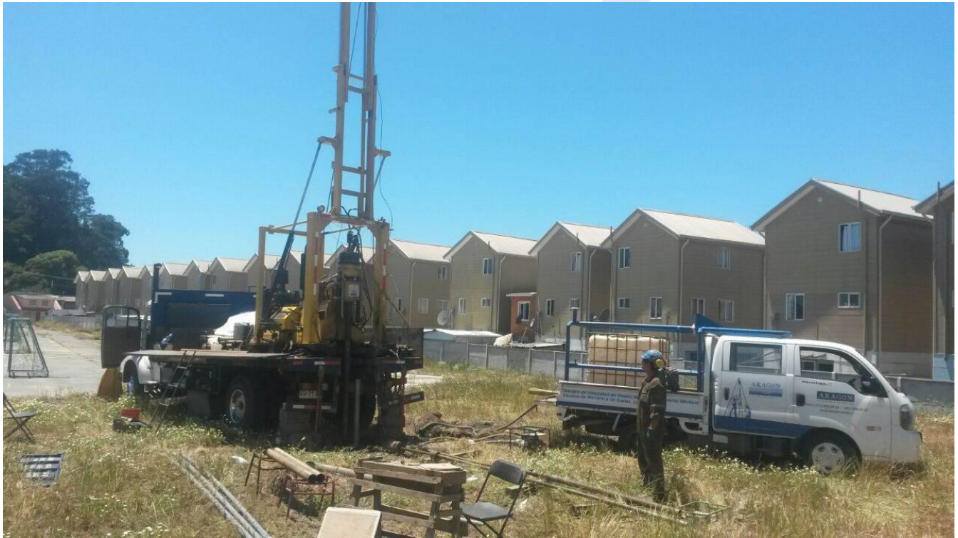
Figura 4.8: Emplazamiento de sondaje SPT-3 de 5 m de profundidad
