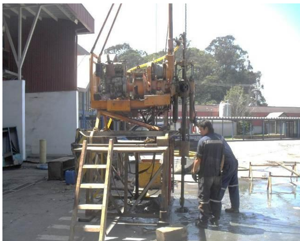
Figura 4.39: Ejecución de sondaje SPT-17 de 16 m de profundidad (2011)
