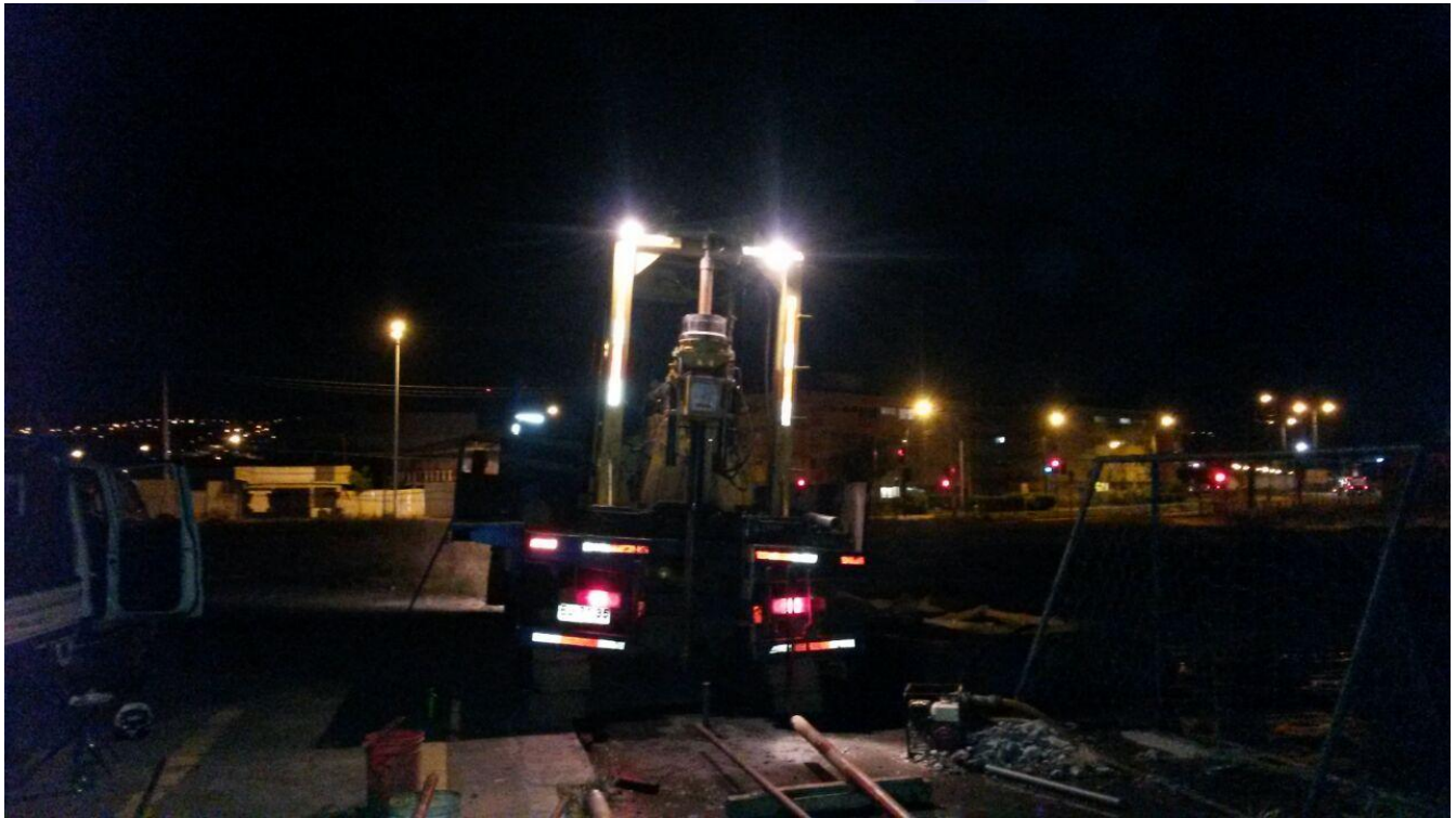
Figura 4.12: Ejecución de trabajos en sondaje SPT-5 de 5 m de profundidad
