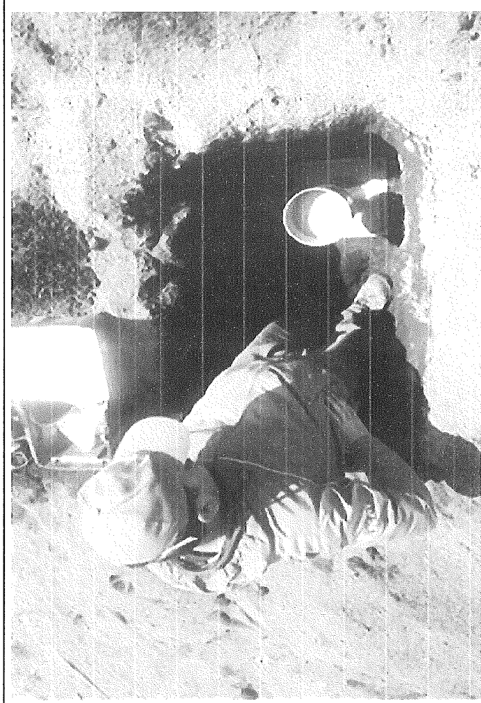
FOTOGRAFIA 56: EJECUCIÓN DE CALICATA N°7
