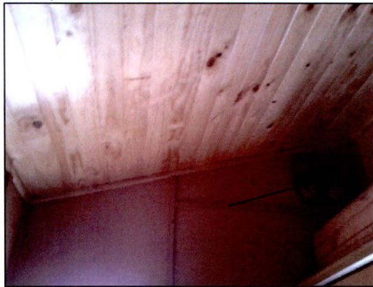
Foto N° 3 Cielo ejecutado, celosía tapada.
