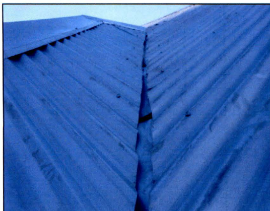
Foto N° 27 Corte de planchas en limahoya.
