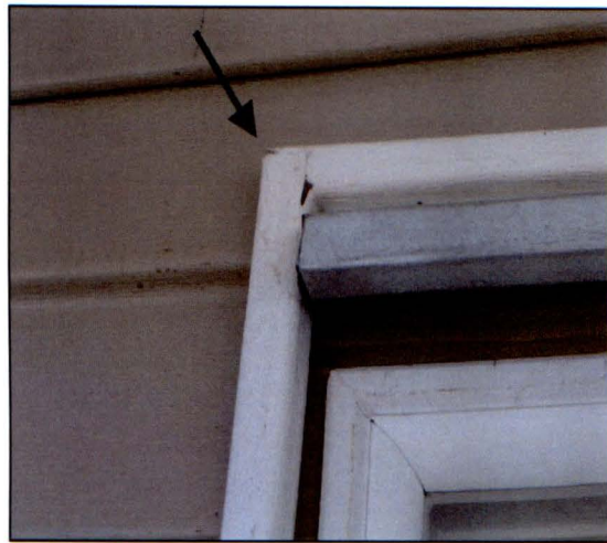
Foto N° 20 Corte en 45° de puerta de acceso.
