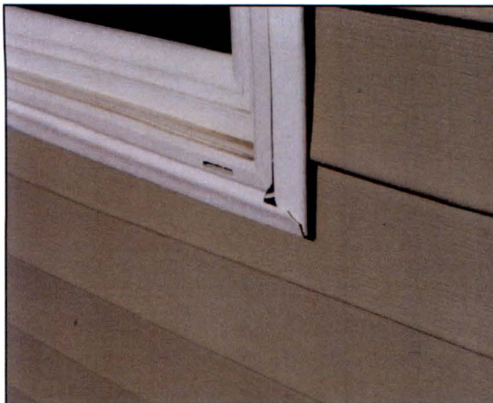
Foto N° 21 Corte en 45° de ventana.
