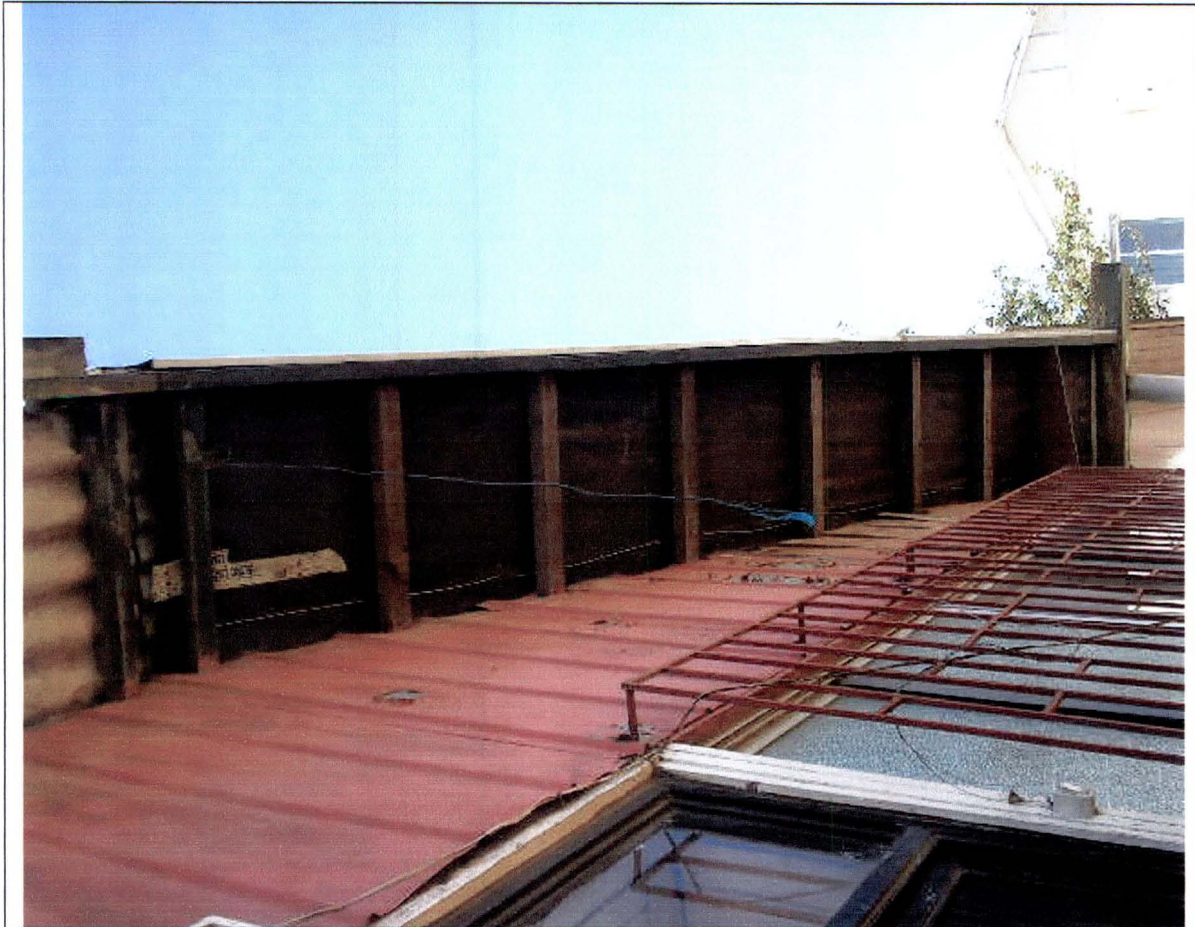
Costaneras en la vivienda de don Juan
