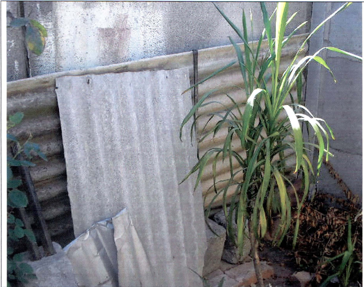
Escombros en vivienda de don Orlando
