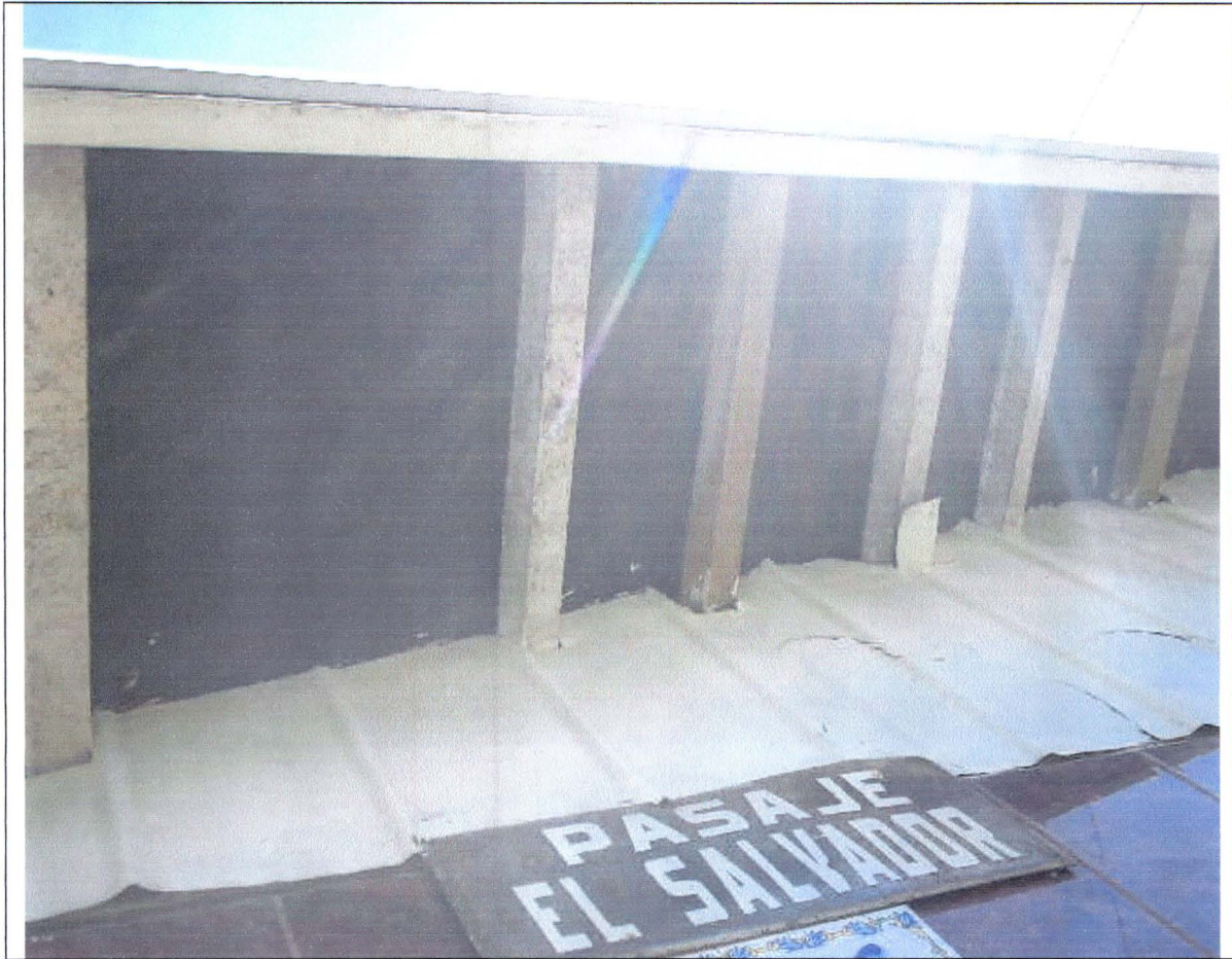
Costaneras, vivienda de don Orlando
