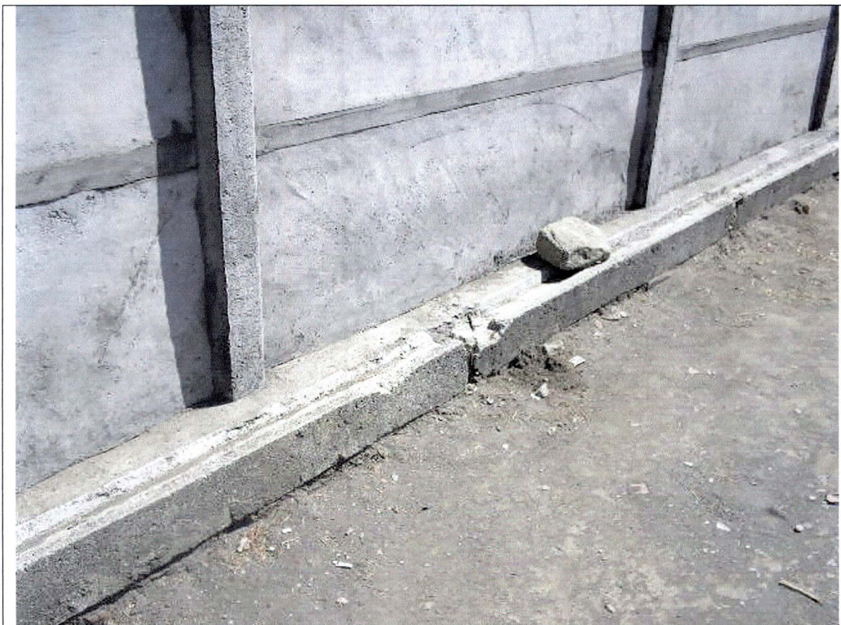
Pilares Acostados para cerrar abertura, vivienda de don Orlando
